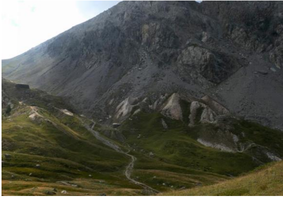
Befestigungsanlagen Opera Valle Alpino
